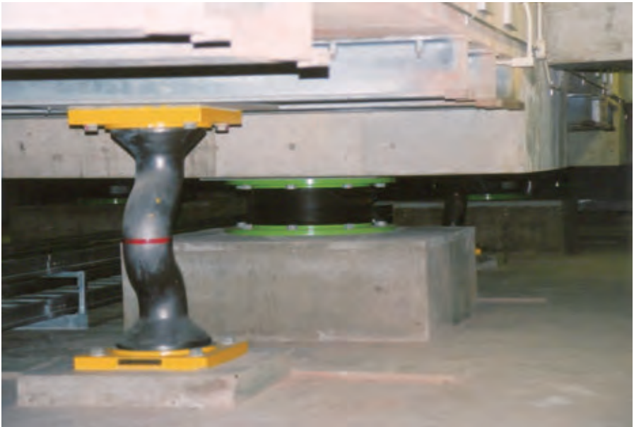
免震装置を設置するため、ジャッキで建物を支え、基礎部分を撤去
