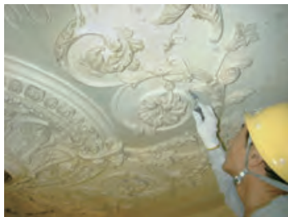
天井の漆喰装飾を復元する様子
