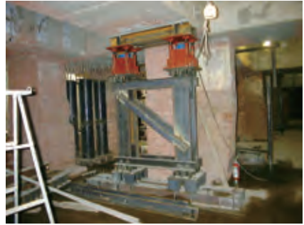
免震装置を設置するため、ジャッキで建物を支え、基礎部分を撤去
