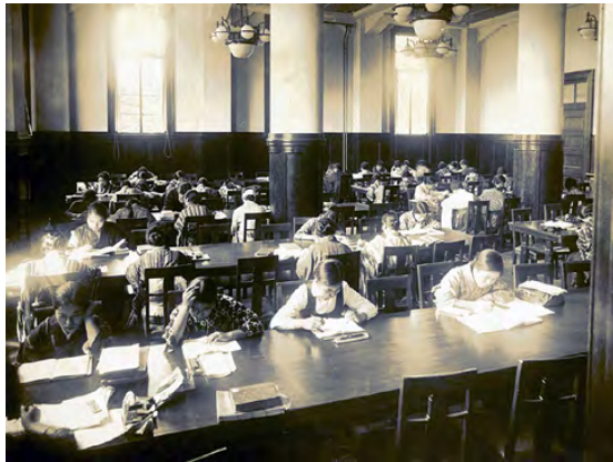
撮影：1929（昭和4）年～1945（昭和20）年 旧：2階 婦人閲覧室 現：2階 調べものの部屋 2階（昭和期増築部分）の閲覧室に隣接して設置されていた婦人閲覧室です。
