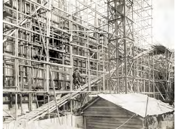
撮影:1902(明治35)年~1905(明治38)年 現在のレンガ棟の工事の様子。レンガを積み上げるための足場を組んでいるのがわかります。
