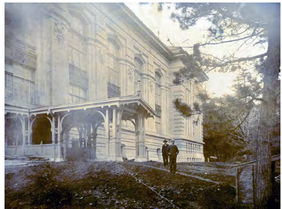
撮影：1929（昭和4）年頃 旧：東側外観 現：東側外観 左手前に明治期建築部分以外の建物が見え、工事物品も見えることから、昭和期増築工事中の写真と思われます。車寄せの通路も未舗装です。
