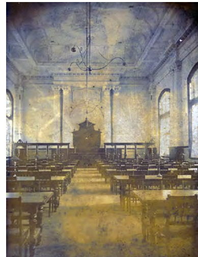
撮影:1906(明治39)年頃 旧:3階 普通閲覧室 現:3階 本のミュージアム 上部シャンデリアにまだガラス傘が設置されていない様子が見えます。工事完成前のものと推測されます。
