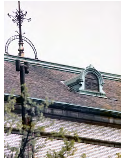
撮影：戦後(昭和) 旧：東側外観 現：東側外観 支部上野図書館時代の写真です。屋根はスレート葺きです。左側に見える飾りは避雷針です。
