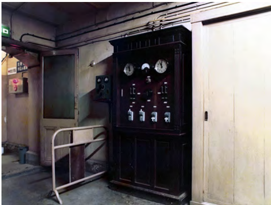
撮影：戦後(昭和) 旧：地下 現：地下（免震層） 図書館の時計を集中管理していた設備です。地階にあり ました。
