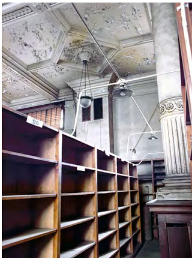
撮影：戦後(昭和) 旧：2階特別閲覧室 現：2階児童書ギャラリー 支部上野図書館では図書出納室として利用されていました。天井部分の漆喰などが剥離しているのが見えます。
