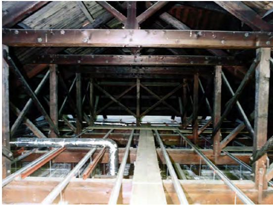
撮影：戦後(昭和) 旧：屋根裏 現：屋根裏 明治期建築部分の屋根裏にある木製小屋組みです。
