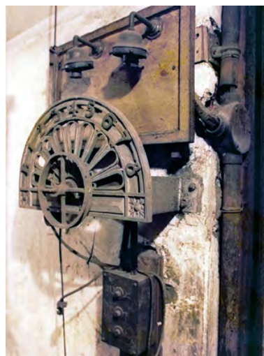
撮影：戦後(昭和) 旧：書庫 現：書庫 現在は撤去された本のエレベーターの設備。地階から8層までの表示が見えます。書庫から閲覧室への資料の搬送に使っていました。
