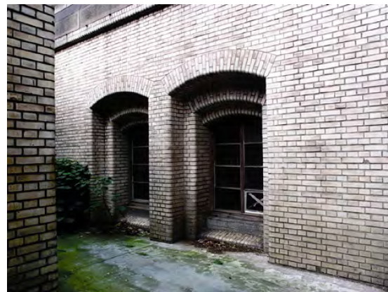
撮影：戦後(昭和) 旧：東側外観(地下) 現：東側外観(地下) ドライエリアから地階窓を撮影した画像です。現在では免震層になっています。
