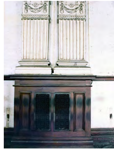
撮影：戦後(昭和) 旧：3階閲覧室(明治期建築部分) 現：3階本のミュージアム 壁面の柱部分です。写真下部にある金属部分は明治に作られた際に空調として用意された設備跡です。明治時代の日本にはこの部分に合う空調設備がなく、後世に設置されることを期待してダクト部分のみが制作されたと言われています。
