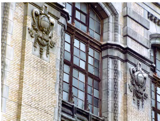
撮影：戦後(昭和) 旧：東側外観 現：東側外観 支部上野図書館時代の写真です。窓の建具は、現在はアルミのサッシに交換されていますが、当時は木製のものを使用していました。
