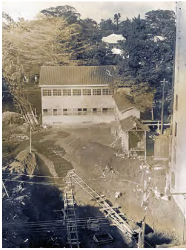
撮影：1952（昭和27）年頃 旧：北側外観 現：北側外観 旧コンクリート造書庫の増築工事中の様子です。土などを運ぶための軌道が見えます。正面に見える建物は旧木造書庫です。
