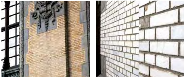
東側(レンガ棟正面)はフランス積みの「ゴマ掛け煉瓦」。 レンガ棟1階から3階の西側(中庭側)の壁は、表面に釉薬を掛けた、既存の外壁「白薬掛け煉瓦」と白丁場石からできている。
