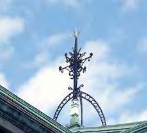
元は鋳鉄製であったものをアルミで作直した避雷針。
